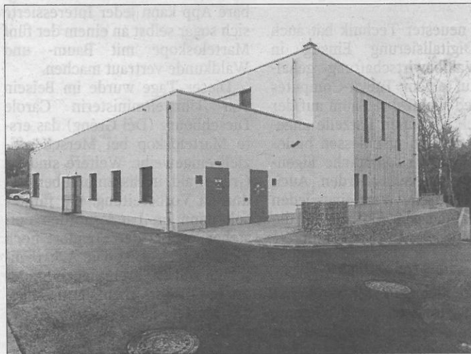
Die Schlafsäle in Findel werden ab Montag zwischen 22 und 8 Uhr geöffnet sein.
